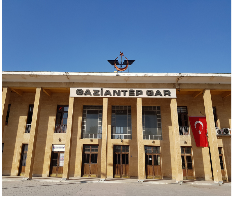
Şekil 1. Gaziantep Gar Binası Ön Cephe (Görsel: Ali Sina Açıklol)
