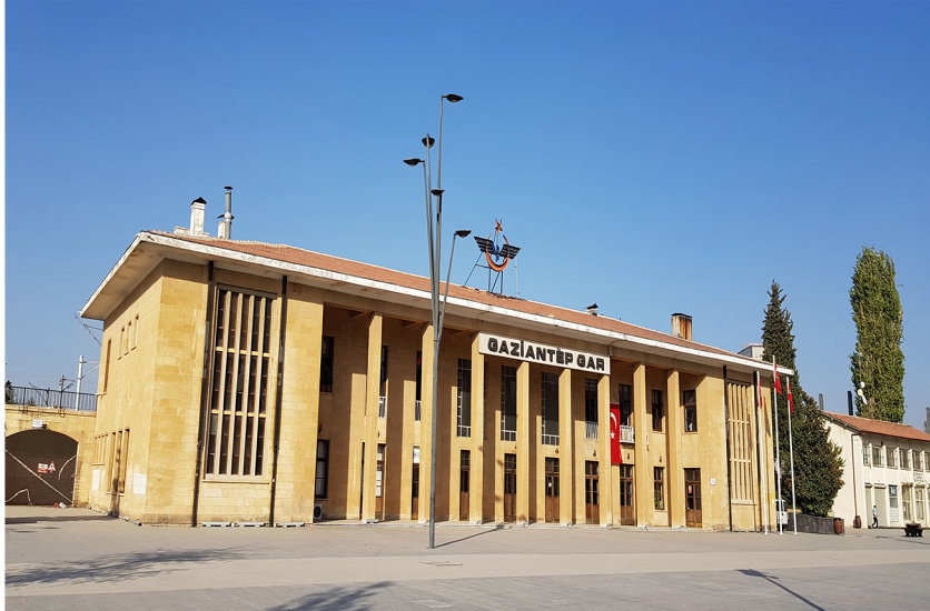
Şekil 2. Gaziantep Gar Binası Güney Görünüşü (Görsel: Ali Sina Açıklol)
