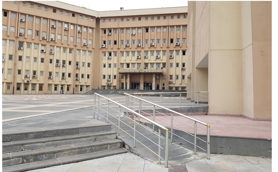
Şekil 4. Engelli Rampası (Görsel: Ali Sina Açıkcol)
