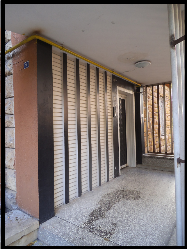
Şekil 4. Giriş saçağı cephe düzenlemesi (Görsel: Feyza Kuyucu)
